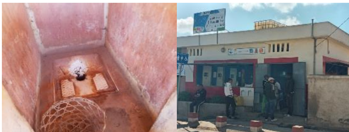
Photo 9: WC dans la cour de l'EPP CENTRE I – Un Bloc Sanitaire construit par PRACTICA situé devant Gare FCE
