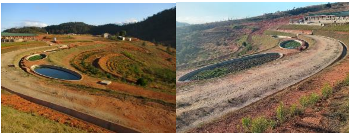
Photo 18 : Bassins de lagunage situés en aval des lits de séchage
