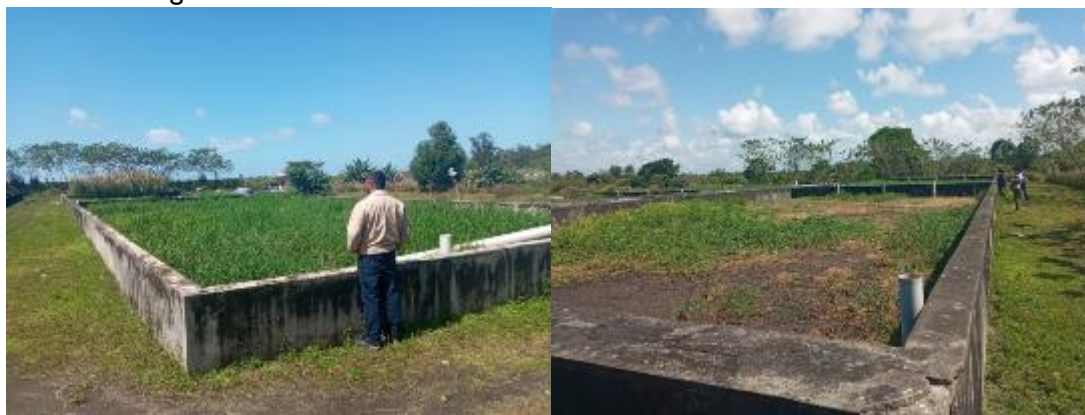
Photo 33: Lits de séchage plantés de CLEAN IMPACT
