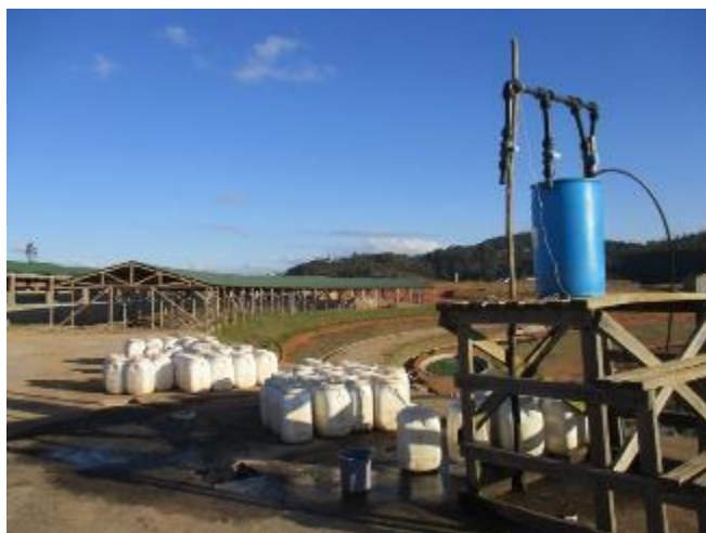
Photo 20 : Aire de lavage
