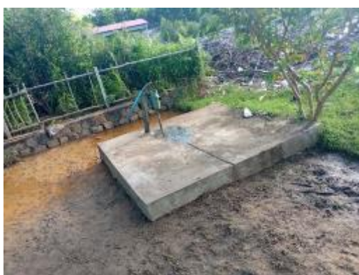
Photo 54: Aire de lavage muni d'une Pompe « Tany »
