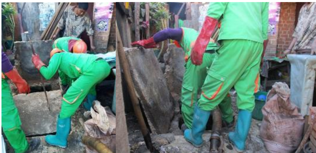
Photo 13: Vidangeurs d'ECODIO en pleine opération de vidange d'une fosse septique d'un particulier
