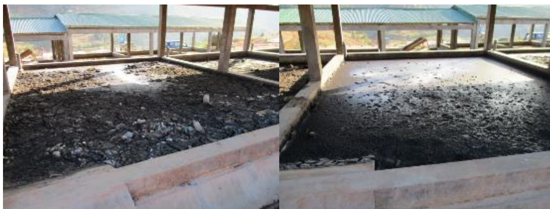
Photo 16 : Boue étalée sur le lit provenant d'une fosse simple (à gauche) avec des déchets plastiques – Boue provenant d'une fosse septique (à droite) plus liquide
