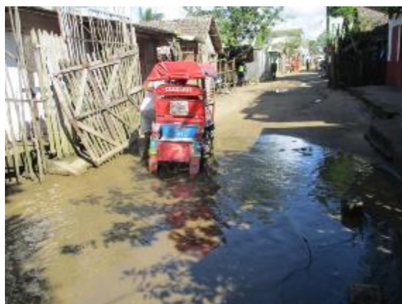
Photo 46: Eaux pluviales et usées éparpillées dans la rue
