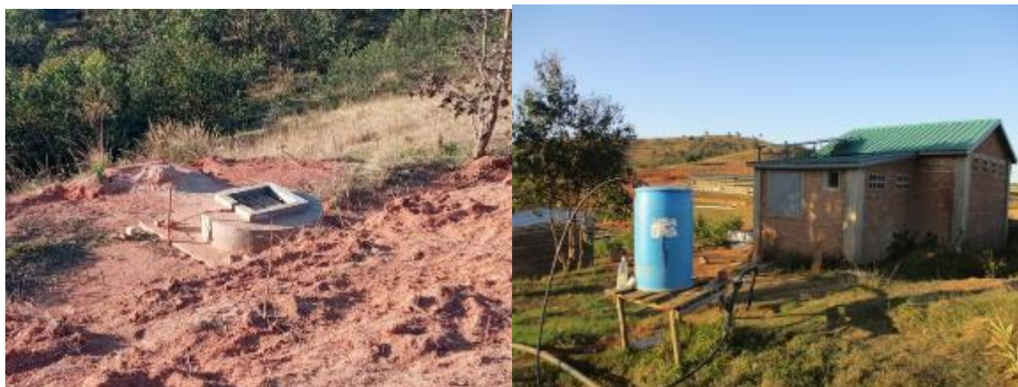
Photo 22 : Puits de captage – Réservoir de pompage
