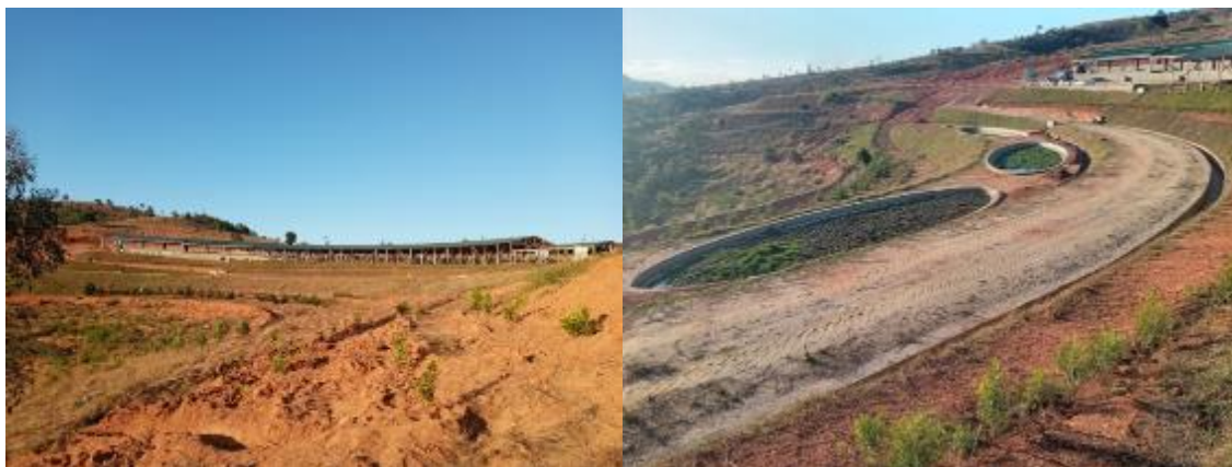
Photo 11 : Vue globale de la station de traitement
