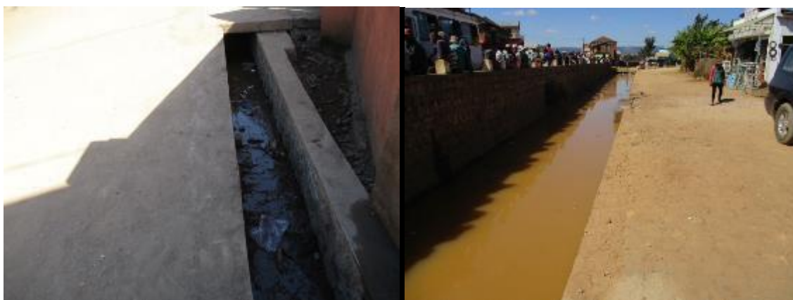
Photo 65: Assainissement routier et canal d'irrigation près du stationnement de Taxi-brousse dans la ville d'Ambohibary
