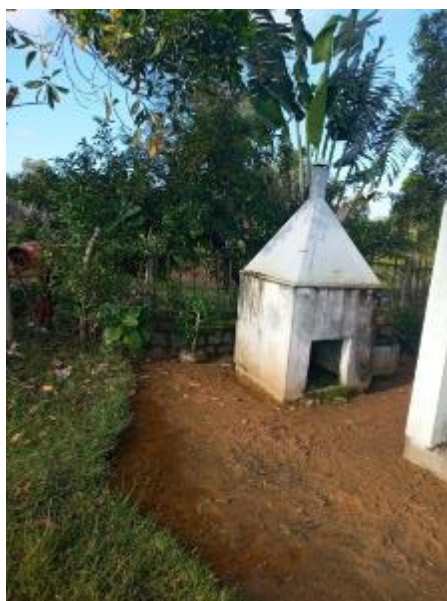
Photo 55: Incinérateur dans la STBV de Mahatsaranarana
