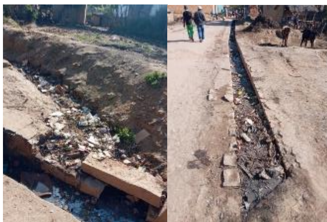
Photo 10: Assainissement routier dans le Fokontany de Sahalava
