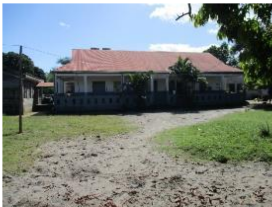
Photo 43: CSB II à Foulpointe
