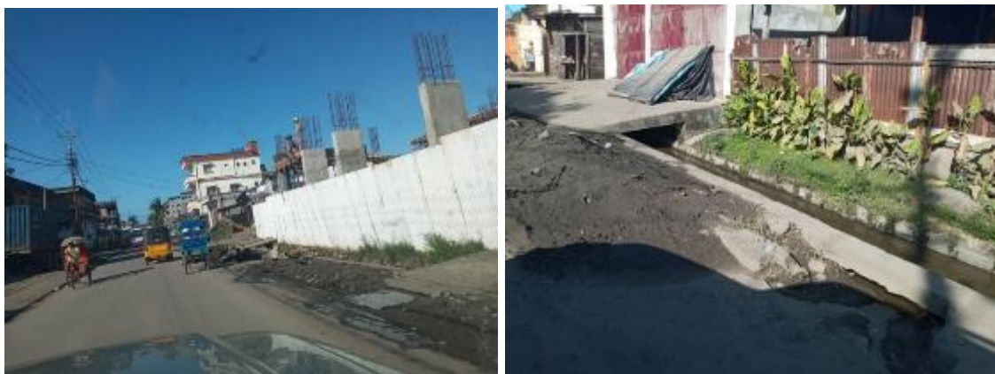
Photo 31: Assainissement routier de la ville
