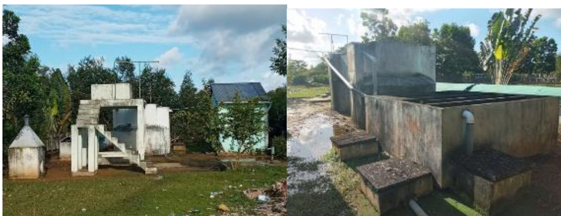
Photo 47 : Station de Traitement de Boue de Vidange à FOULPOINTE
