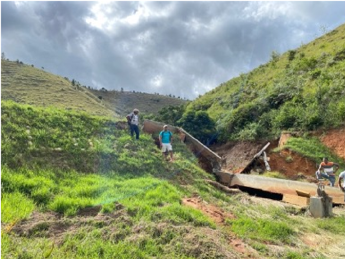
Illustration de la rupture du barrage lors de la visite du chef de projet (23/03/2022)
