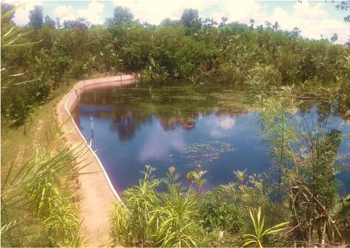
Figure 4. Barrage réalisé en moins de 3 mois – après construction
