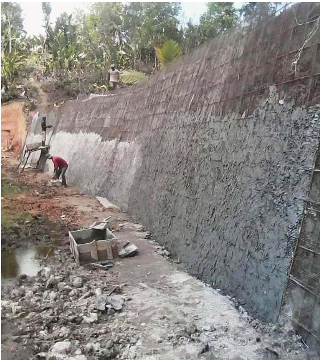
Figure 8. Économie en bois de coffrage lors de la mise en œuvre d'un barrage de hauteur moyenne de 4 ml (préservation de l'environnement)
