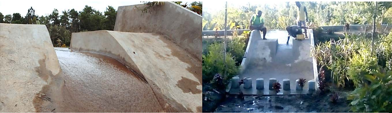
Figure 7. Évacuateur de crue en ferrociment
