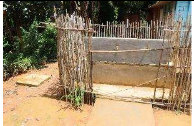
Photo 3: DLM avec Plomberie en bon état
