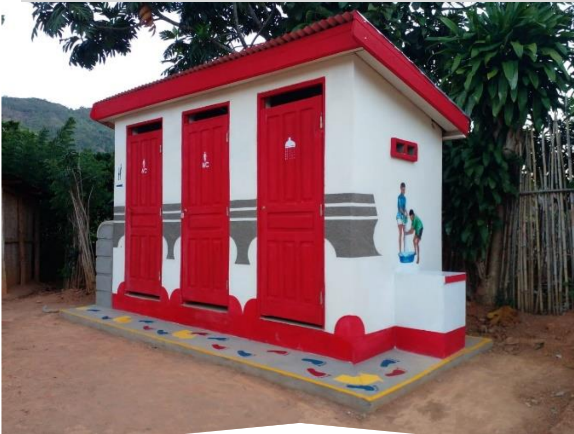
Latrine avec Nugdes au CSB 2 Lokomby (Fitovinany)
