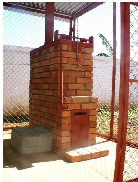
- Figure 4 : L'incinérateur De Montfort
